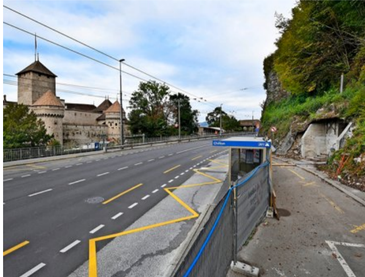
Beaucoup ignorent qu'un dédale de plusieurs kilomètres de galeries existe dans la roche en face du château de Chillon.
